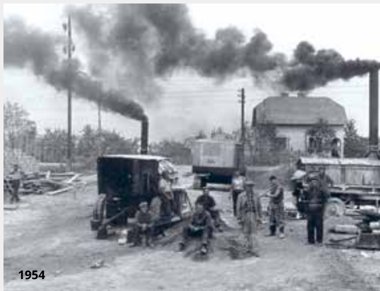
Polaganje temeljev za Centralno skladišče Ljubljana
