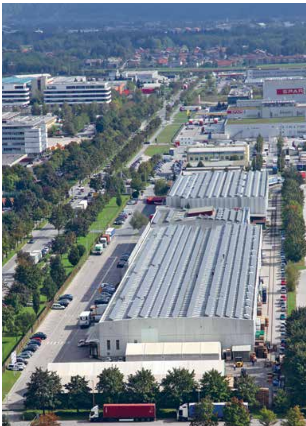
Sončne elektrarne na strehah dveh logističnih zgradb na površini 13.000 m 2 in z močjo 900 kWp proizvedejo 1 milijon kWh električne energije na leto
