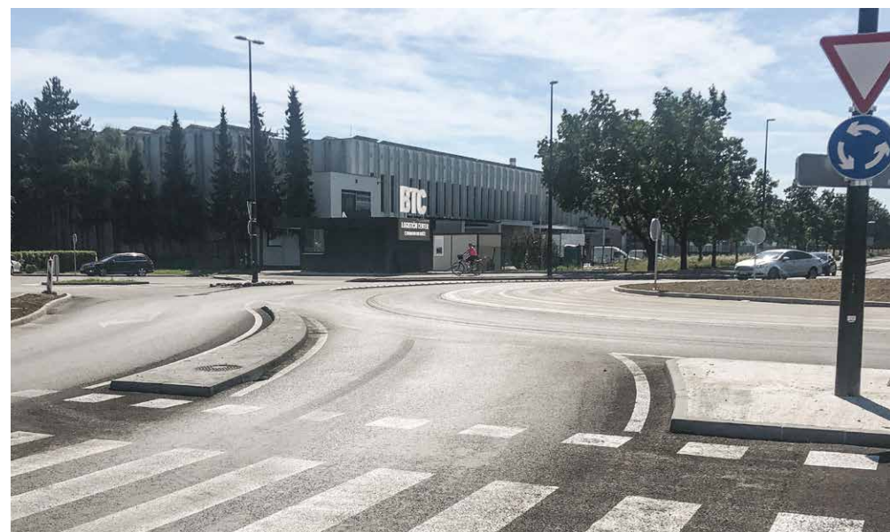
▲ Prenovljena Letališka cesta z novim krožiščem in predvidenimi označbami – vhod Logistični center
