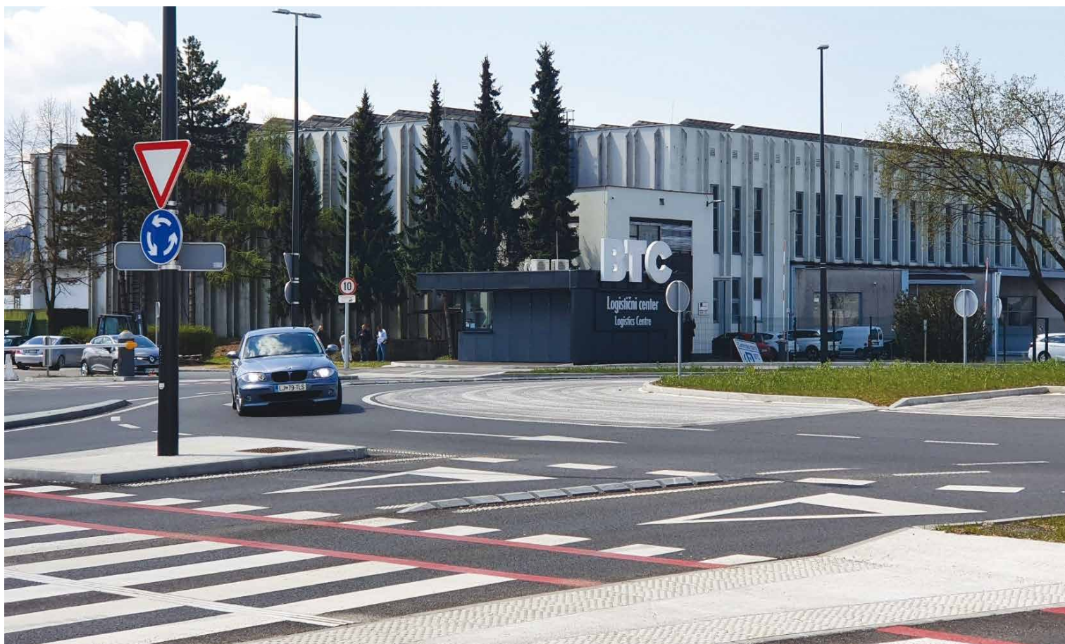
▲ Prenovljena Letališka cesta z novim krožiščem in novim vhodom v BTC Logistični center
