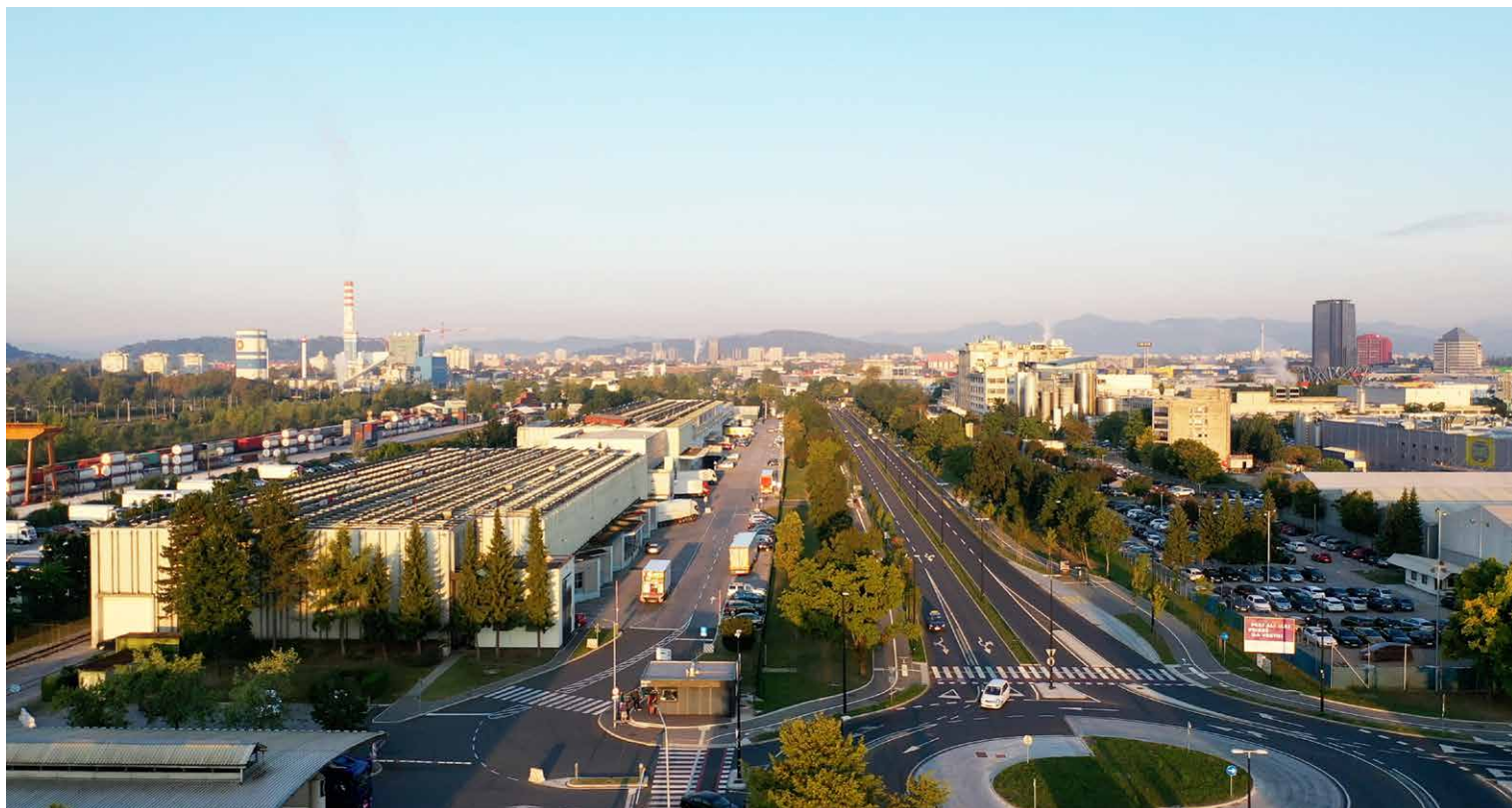
▲ Prenovljena Letališka cesta z novim krožiščem in novim vhodom v Logistični center BTC
