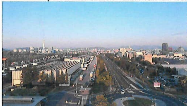
Slika: Prenovljena Letališka cesta z novim krožnim križiščem in novim vhodom v Logistični center BTC
