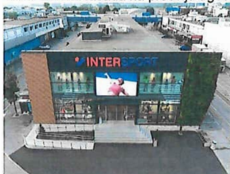
Slika: Zelena fasada na pročelju trgovine Intersport
