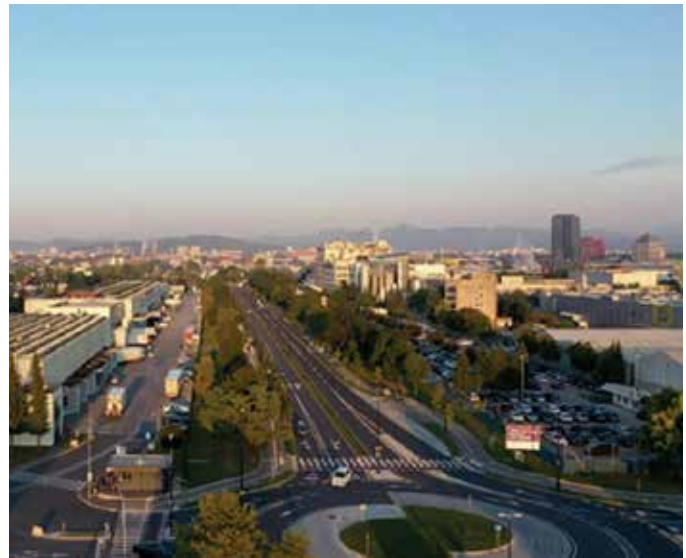
Prenovljena Letališka cesta z novim krožiščem – vhod v Logistični center BTC
