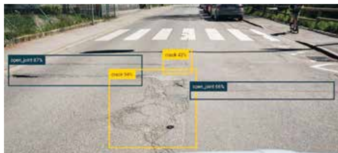
Pilotni projekt inteligentnega sistema za upravljanje cest
