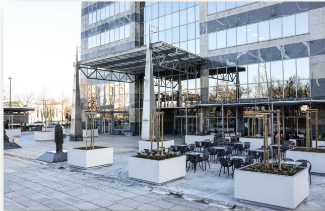
Slika: Prenovljen urbani prostor pred Poslovno stolpnico v BTC Cityju Ljubljana
